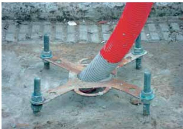
Detalle de realización de cimentación con pernos sueltos y plantilla.
